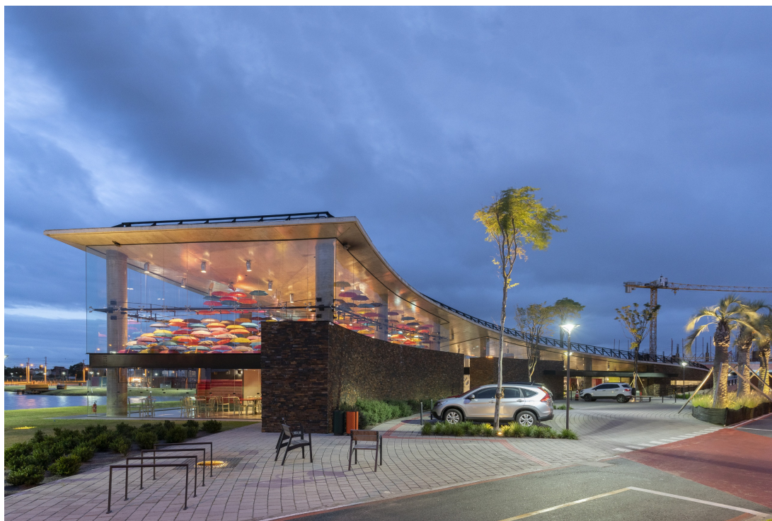
Figura 2. Vista frontal mostrando o trecho mais alto do edifício. Fotógrafo – Cristiano Bauce
