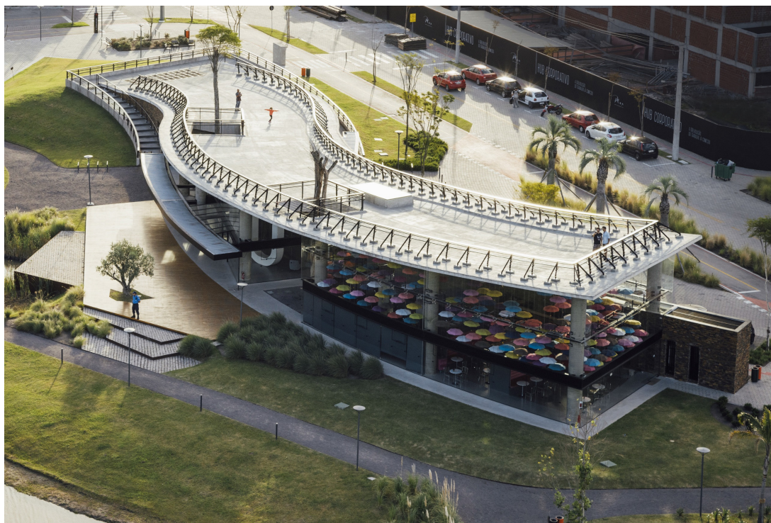
Figura 1. Vista aérea da edificação, mostrando a cobertura mirante. Fotógrafo – Cristiano Bauce
